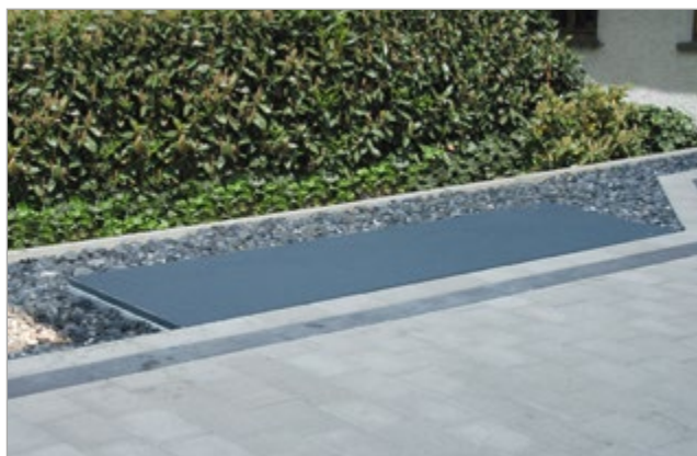
Falls der GeoTainer® Modell GT im Gehbereich eingebaut wird, kann dieser auch mit einer Anti-Rutsch-Beschichtung (rotbraun oder schwarz) ausgestattet werden.
