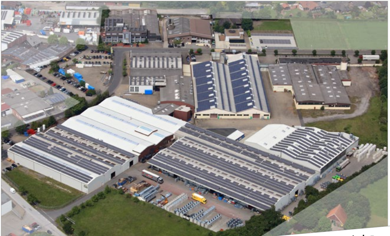
Fabriek I en kantoren Südlohn
